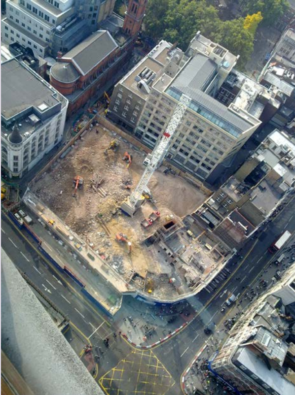
Safle adeiladu Crossrail yn Tottenham Court Road
